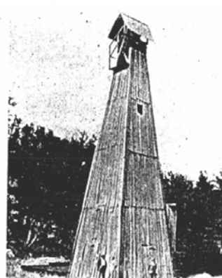
Pozzo Cavone m. 108
